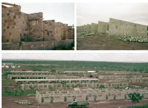
**Figura 2.** Processo construtivo tradicional – p.ex. tijolo cerâmico de 8 furos com estrutura autoportante – aplicado nas casas geminadas da Asa Sul. (fonte: montagem elaborada pelas autoras, 2022, com base em fotos do ArPDF).
